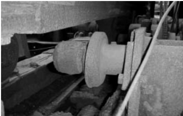
Foto 2.4.5: abgebrochene Auflagerrolle
