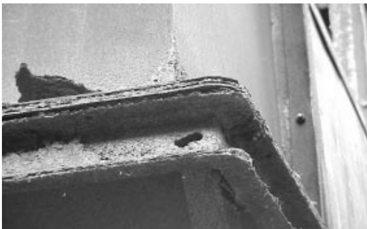
Foto 3.10.3: Durchrostungen und Aufblätterungen an Rahmen Stampferraum
