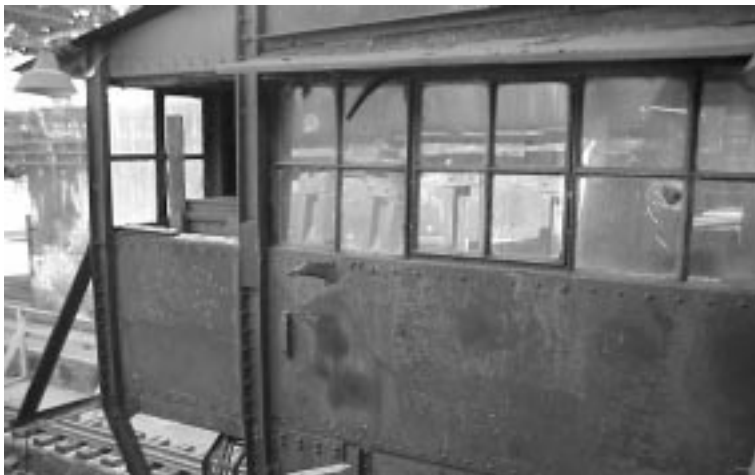
Foto 2.9.1: Außenansicht Fahrstand (Kokereiseite), ganz links: Erweiterung Fahrstand
