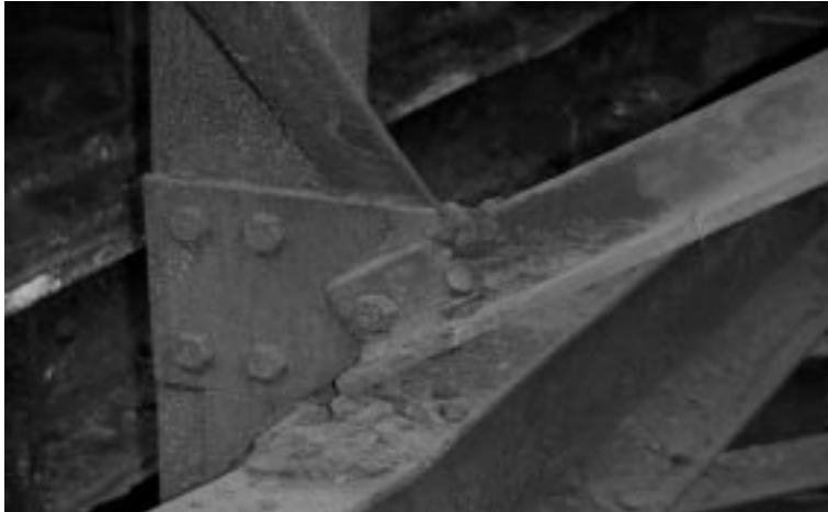
Foto 3.10.4: Knotenblech in gutem Erhaltungszustand im Traggerüst Fahrstand
