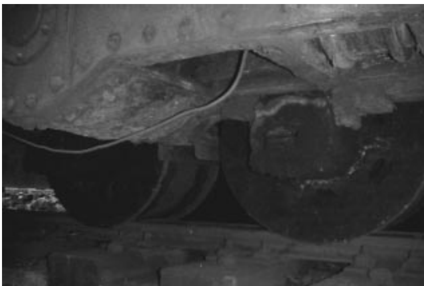
Foto 2.2.8: Untersicht eines Radgestells
