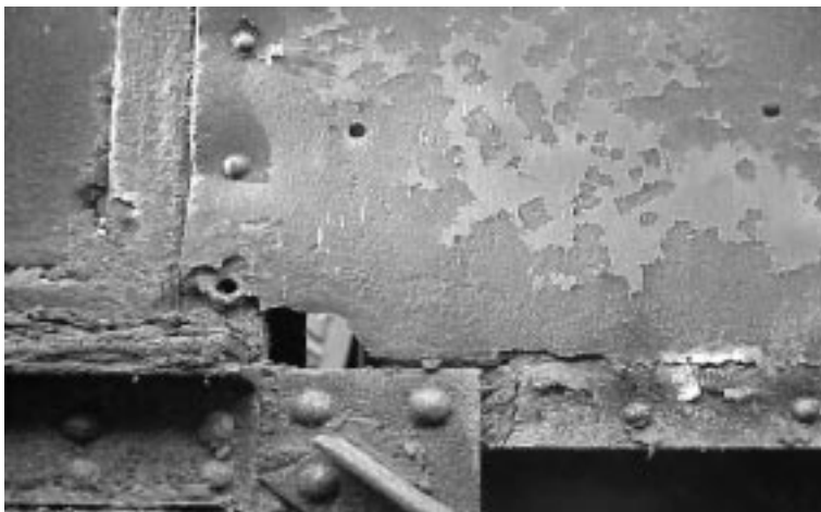
Foto 3.10.5: Durchrostungen an Blechverkleidung Stampferraum
