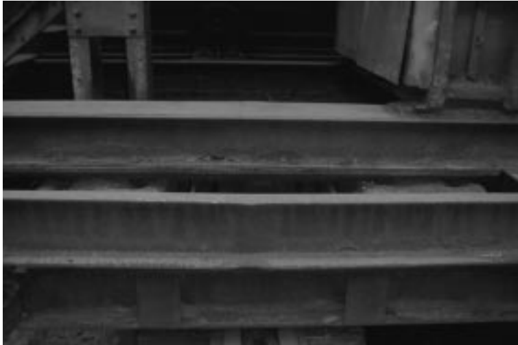
Foto 2.2.9: Unterer und oberer Maschinenrahmen mit Auflagern
