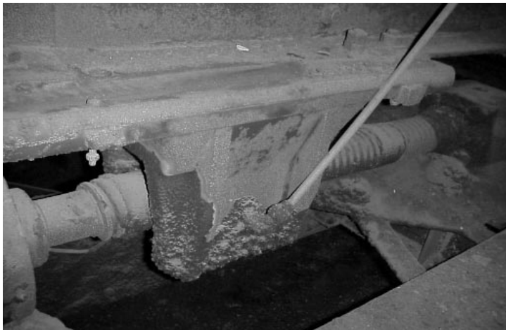
Foto 2.2.13: Spindel (Unterrahmen) mit Spindelmutter (Oberrahmen)
