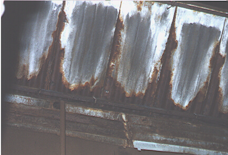
Foto 1.1: Wellblech und Stahljalousien Dachreiter
