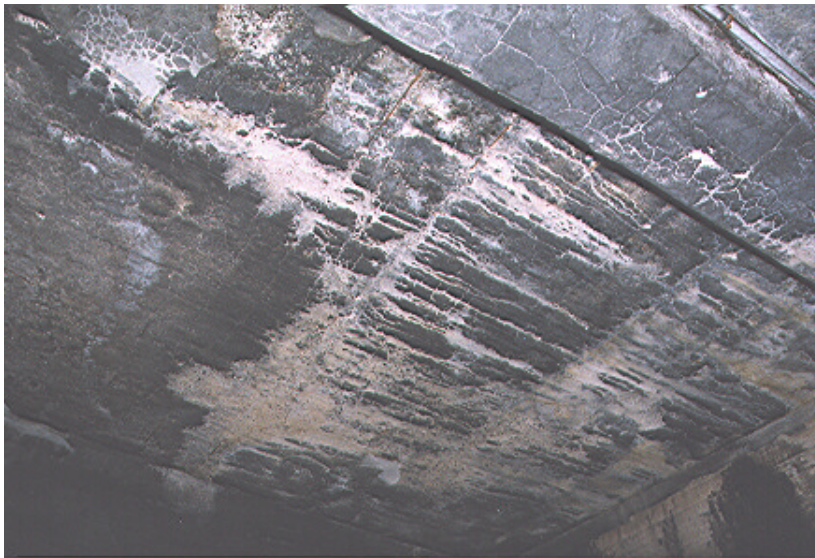
Foto 6.4: Innenansicht Decke Zentraldach
