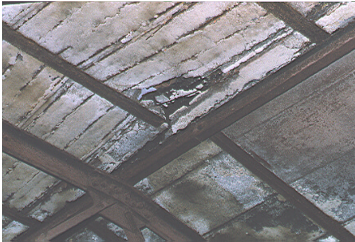
Foto 4.14: Detail Aufbiegung (an Dachfirst)
