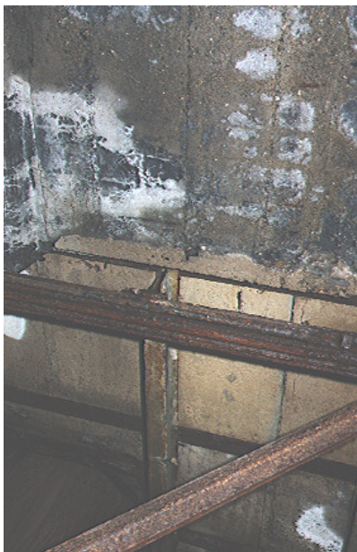
Foto 2.10: Übergang Stahlbeton gegossen / Stahlbetonplatten
