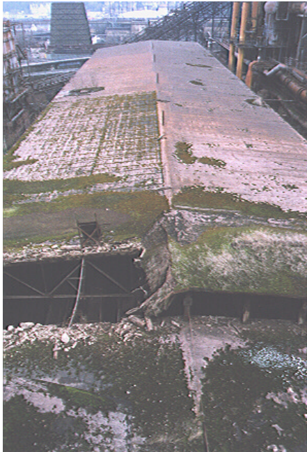
Foto 4.4 Gesamtansicht Dach Möllerhalle
