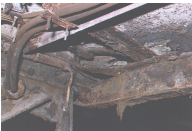
Foto 4.15 Durchrosteter IPE-Träger
