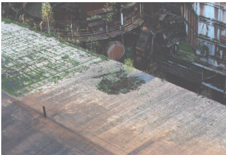
Foto 4.3 Durchbiegung und Bewuchs
