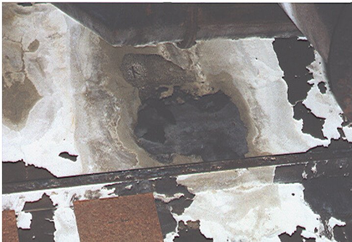
Foto 1.2: Reparaturstellen in Dachfläche 2
