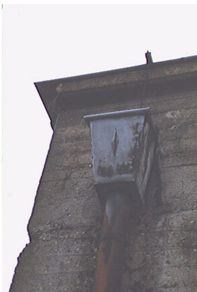
Foto 6.3 Einlauf Fallrohr
