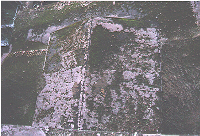
Foto 4.7: Versprödetes Bitumen und typischer Bewuchs
