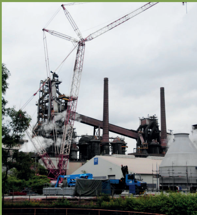
Neuzustellung des Hochofens Foto: © Dillinger Hütte
